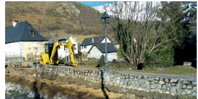
Le Boularic pendant les travaux
