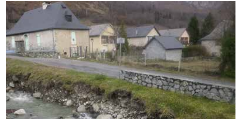
Le Boularic avant les travaux
