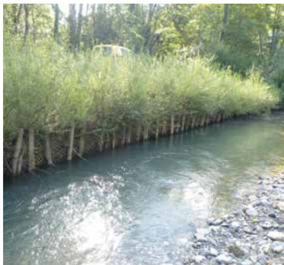
Restoration de berge en génie-végétal du Gave d'Azun
