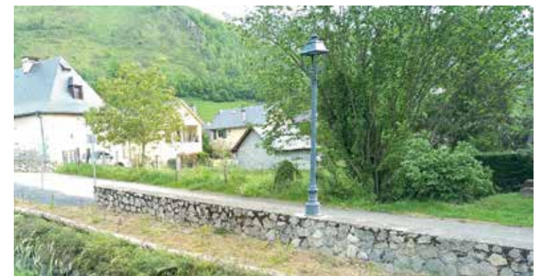
Le Boularic après les travaux
