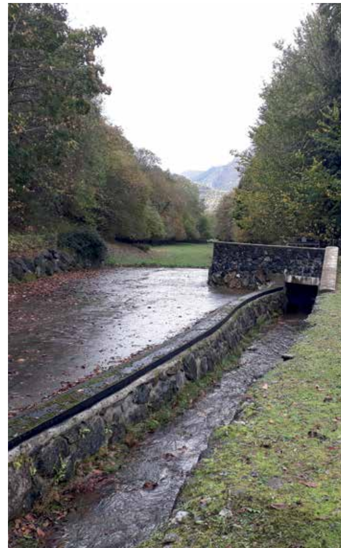
Riu Gros à Geu et son limiteur de débit avec surverse en rive gauche
