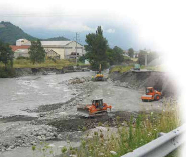
Reconstruction de la route départementale à Villelongue
